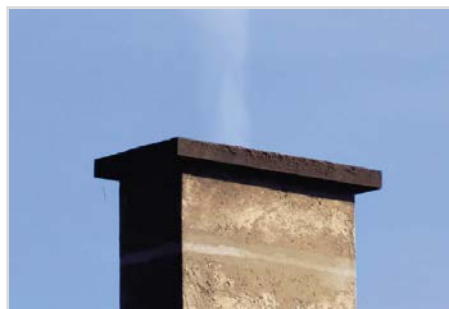
Slika 14; Svetel – neviden dim, razen pare je pokazatelj dobrega zgorevanja, za strokovno presojo so sicer potrebne meritve emisiji
